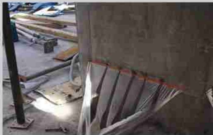
محل اتصال ستون در حال تزریق
