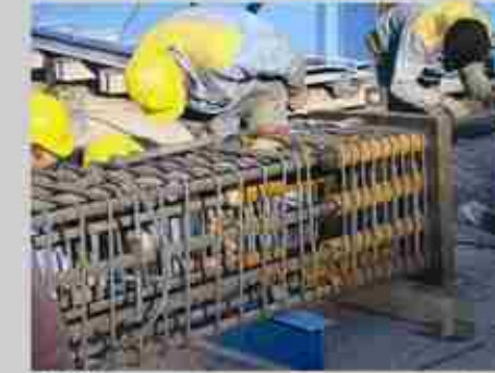
آزماتور بندی ستون پیش ساخته بتنی R-PC
