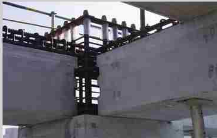
محل اتصال ستون با تیرهای طولی و عرضی
