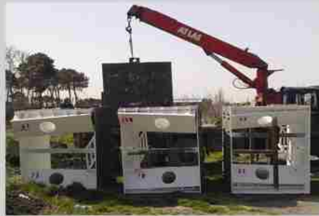
ساخت و نصب باکسهای فولادی پیلون به همراه اتصالات و کیسینگ ها در پل کابلی مشهد
