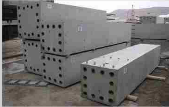
ستونهای پیش ساخته آماده نصب
