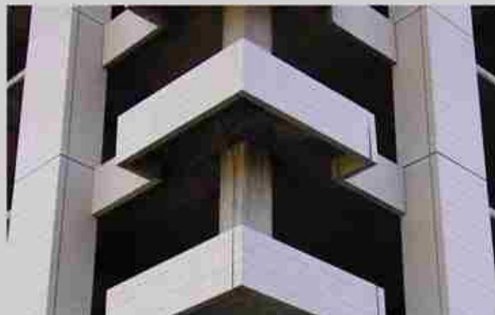
قطعات نصب شده نمای ساختمان به موازت اجرای سازه آن
