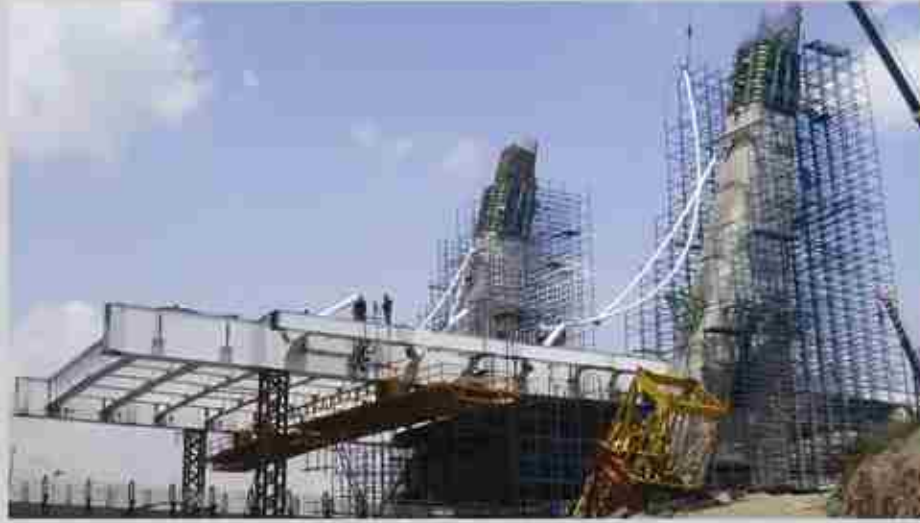
طراحی، ساخت و نصب ۴ دستگاه شاریو در پل کابلی مشهد با قابلیت حرکت طولی و چرخش ۳۶۰ درجه
