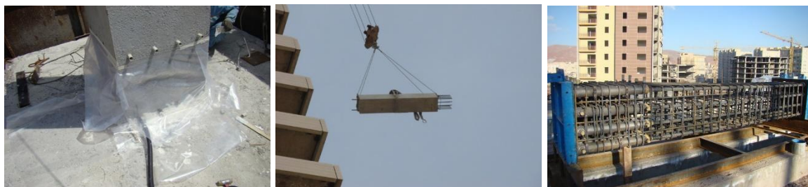
ب- اجرای ستونها به روش پیش ساخته (با اتصالات NMB)
