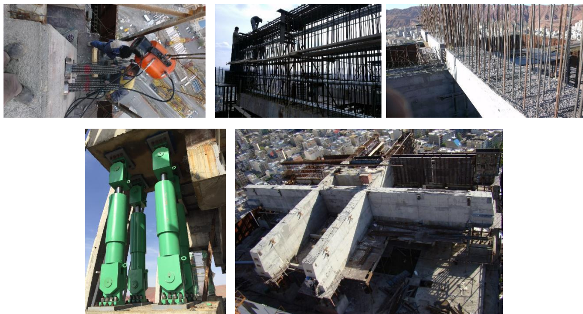
شکل ۸. مراحل مختلف اجرای ابرتیرها و نصب میراگرهای ویسکوز در ساختمان مرکز تجارت جهانی تبریز
