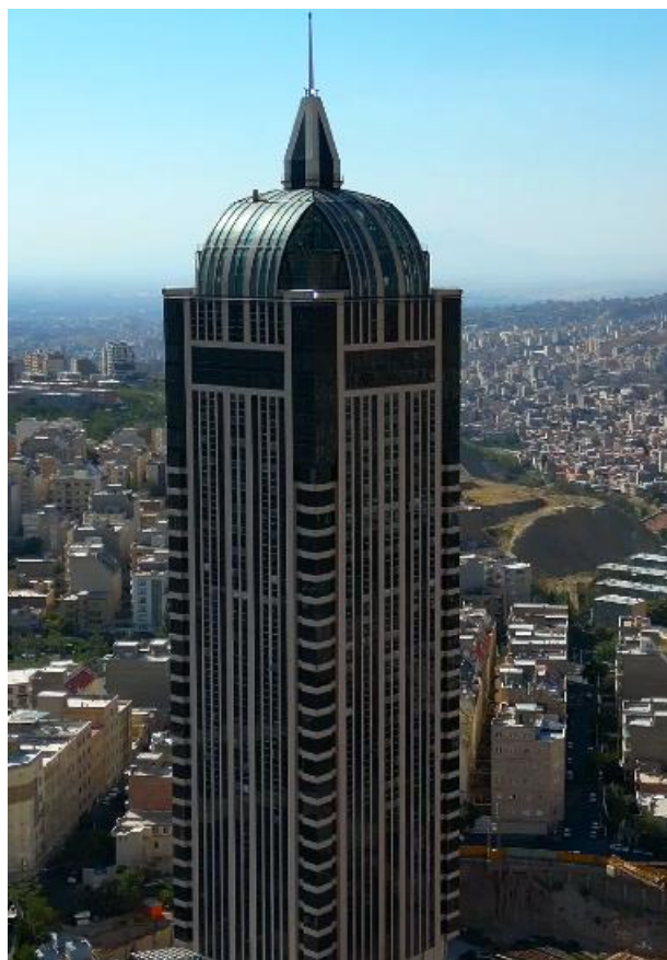
شکل ۳. نمای کلی از ساختمان مرکز تجارت جهانی تبریز
