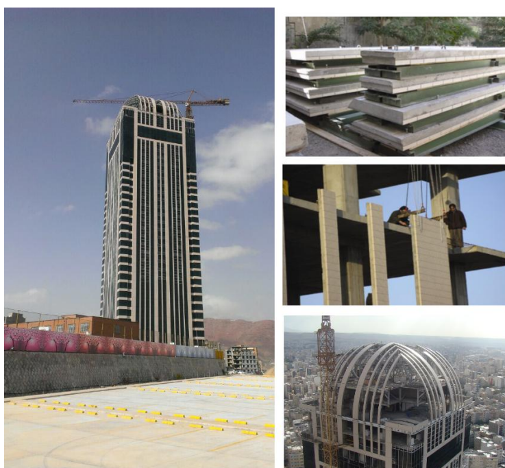
شکل ۹. پانلهای پیش ساخته بکار رفته در اجرای نمای ساختمان تجارت جهانی تبریز
