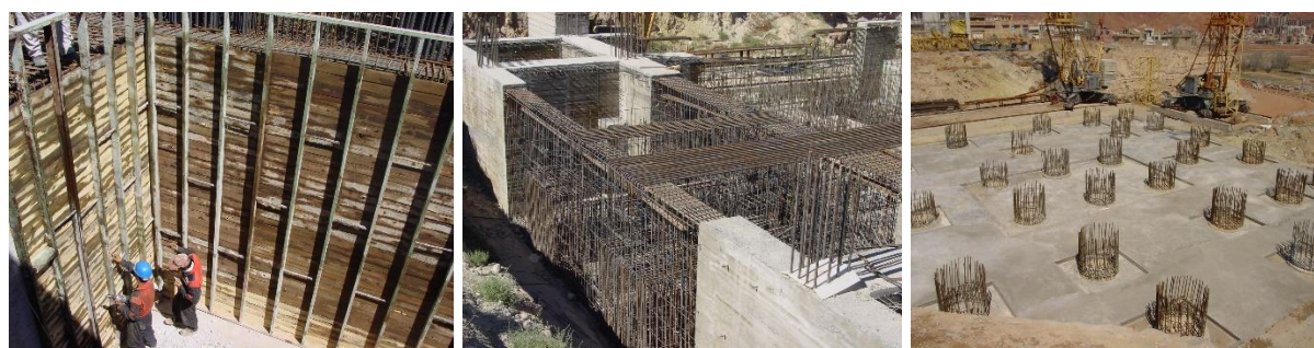
شکل ۴. اجرای فونداسیون جعبه ای ساختمان مرکز تجارت جهانی تبریز
