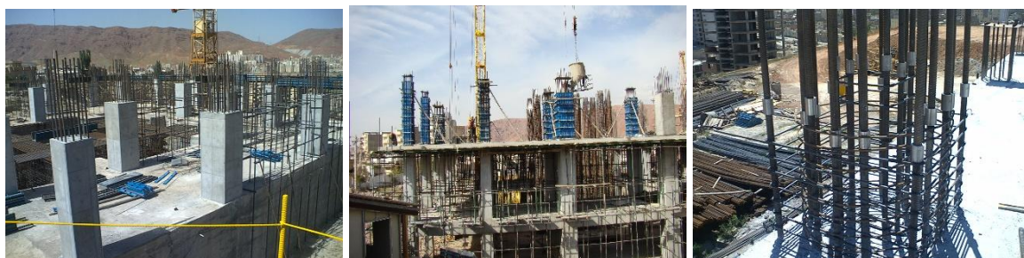
الف- اجرای ستونها بصورت درجا (با اتصالات کوپلر)
