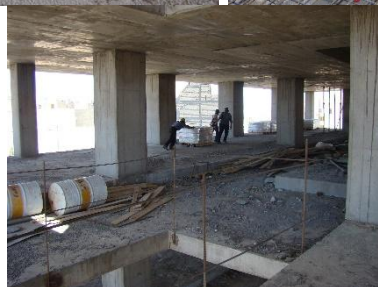
شکل ۷. اجرای دال تخت طبقات در سیستم سازه ای سوپر فریم مرکز تجارت جهانی تبریز
